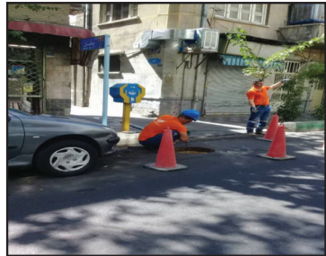
پرسنل امداد در حال باز کردن گرفتگی یک منهول
