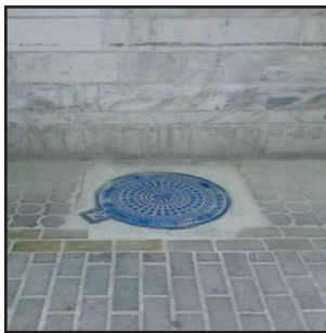
نصب یک دریچه جدید
