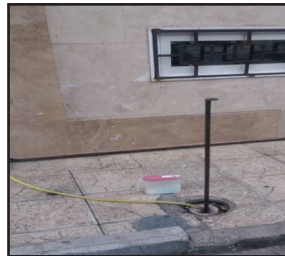
تصویر رفع انسداد سیفون با استفاده از پیستون دسته بلند و مواد شوینده
