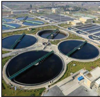
تصفیه خانه جنوب شهر تهران
