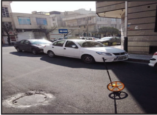
پوشیده شدن دریچه آدمرو با روکش آسفالت
