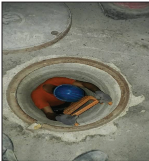
پرسنل امداد در حال ورود به آدمرو برای رفع حادثه
