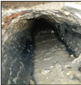
تصویر داخلی یک سیفون که بدلیل انباشت مواد دور ریز آشپزخانه دچار گرفتگی شده است
