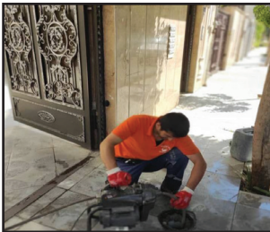
تصویر رفع انسداد سیفون با استفاده از فنر برقی انشعاب
