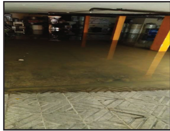
تصویر پس زدگی در رمپ و پارکینگ یک ساختمان بدلیل تراز منفی
