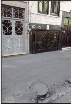
تصویر تخریب دیواره دهانه یک منهول برای هدایت غیر قانونی آب جوی کوچه به داخل منهول
