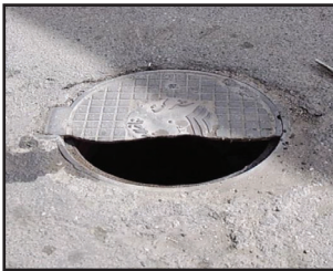
تصویر یک دریچه شکسته شده
