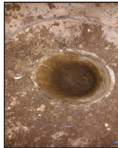
تصویر دهانه یک سیفون که بدلیل پر شدن با مواد چرب و ضایعات باعث انسداد و پس زدگی به داخل منزل شده است
