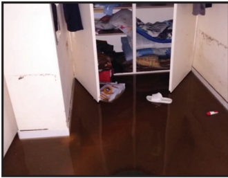
تصویر پس زدگی به زیر زمینی که مسکونی بوده و بصورت غیر قانونی وصل شده است
