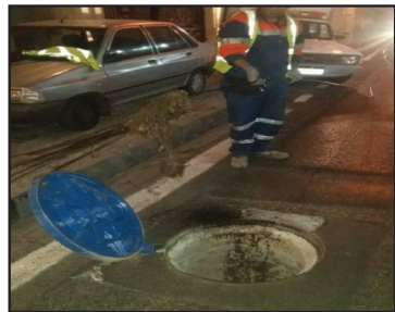
خارج نمودن زباله از داخل آدمرو که باعث گرفتگی شده است
