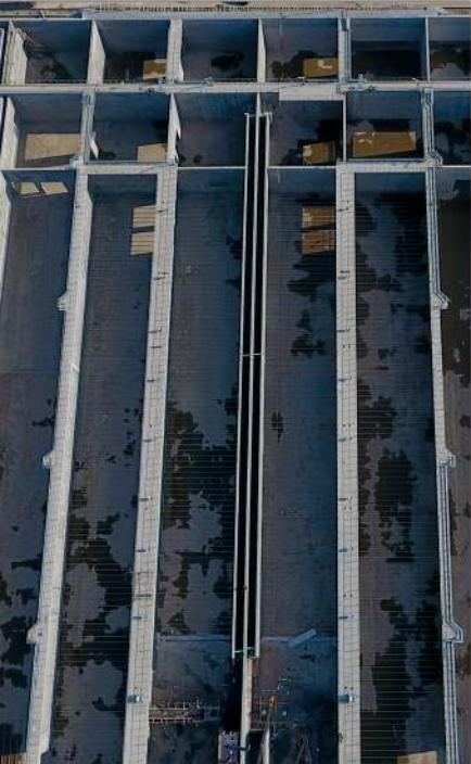
◀ فاضلاب پس از جمع آوری از سطح شهر از طریق تونل به صورت ثقلی وارد تصفیه خانه خواهد شد. در ابتدای فاضلاب از واحدهای آشغالگیری و دانه گیری عبور کرده و وارد واحد ته نشینی اولیه می گردد. سپس وارد راکتور بیولوژیک شده و در آنجا اکسیداسیون بیولوژیکی اتفاق می افتد.
